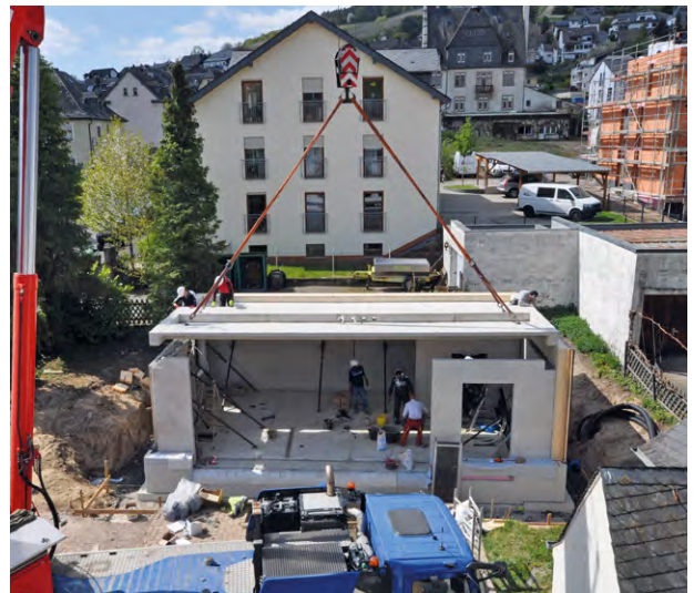
Montage der weitgespannten Deckenplatte für eine Moduleinheit.
