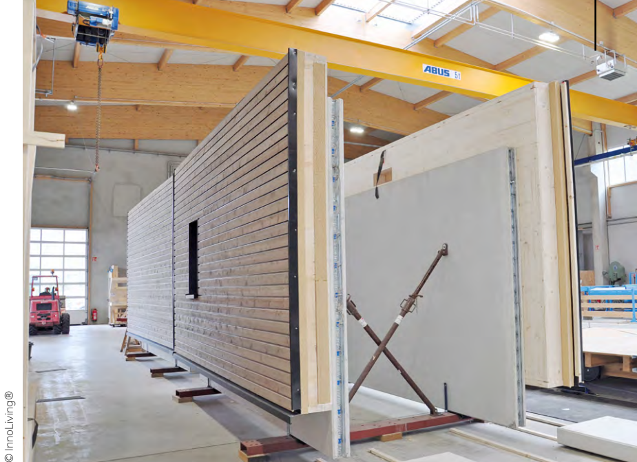
Werkseitige Herstellung der Hybridwand in Holz-Beton-Verbund.
